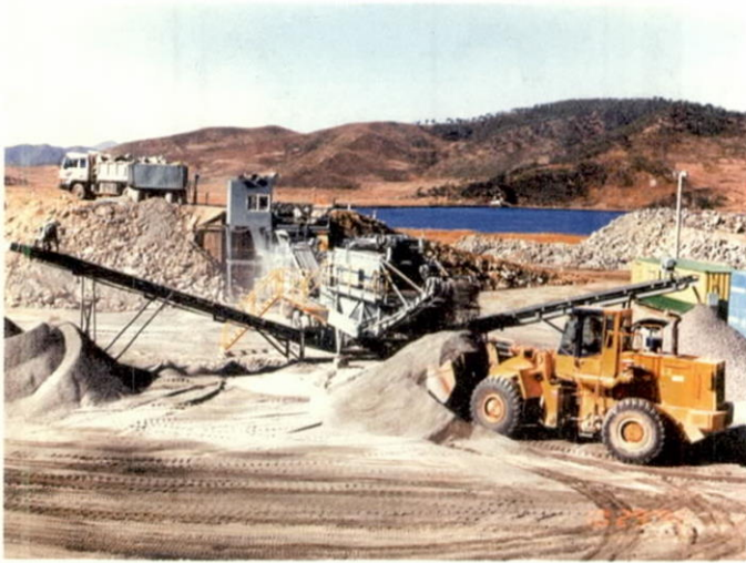
대북 경수로 지원사업 건설 현장
