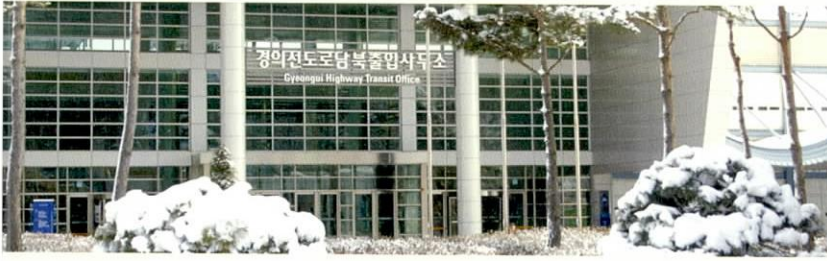
• 경의선 도로출입사무소 외관
