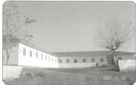
〈개보수 공사 중인 강남군인민병원 입구〉
