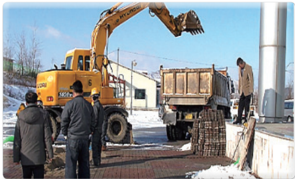
RFID 공사 개시(2013.12.11)
