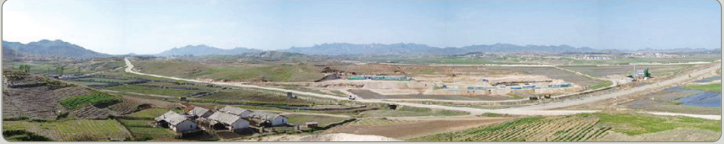
시범단지 토공사 현장(2004.3)
