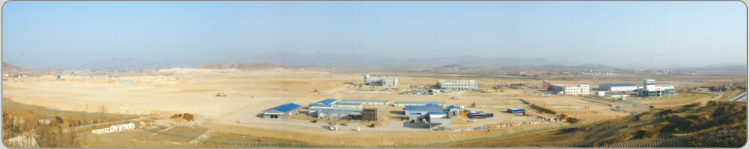
시범단지 입주업체 공장 건축이 진행중인 모습(2005.3)
