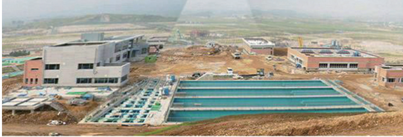
월고저수지로 부터 원수를 공급받아 정수한 뒤, 개성공단과 개성시로 공급하고 있는 개성공단 정·배수장의 시공 중 모습
