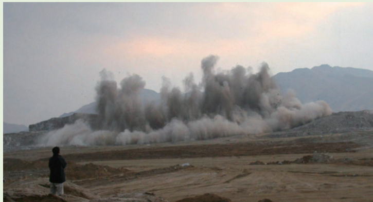
토사제거후 드러난 암석에 화약을 장착, 발파를 시행하는 모습
