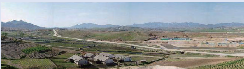
시범단지 토공사 현장(2004.3)
