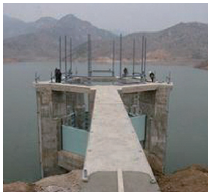
상수원인 월고저수지 내 제방에 방수탑(물을 방류하는 시설)을 건설하고 있는 모습
