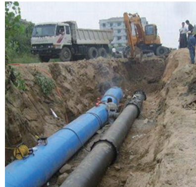
월고저수지에서 개성공단 정·배수장까지 원수를 공급하는 상수관로를 매설하고 있는 모습
