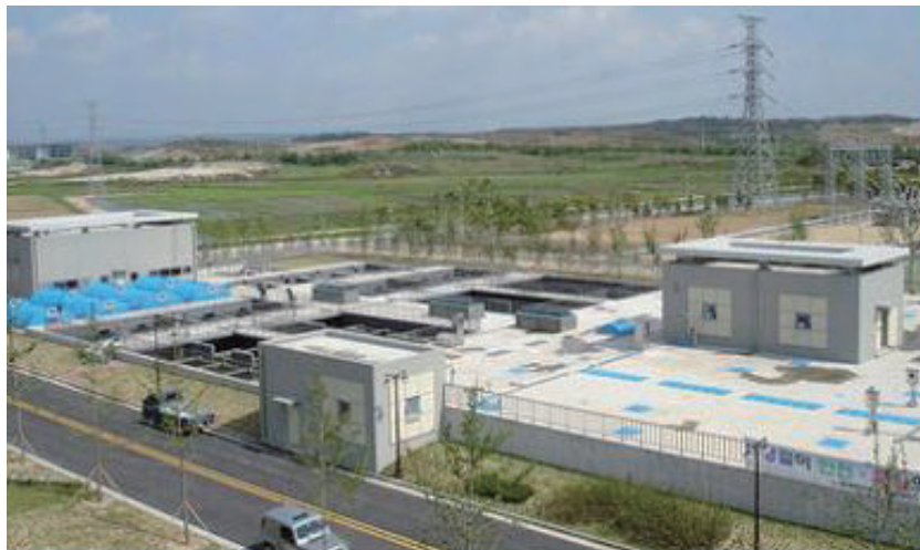
개성공단 내 폐수종말처리장의 수처리 구조물 전경
