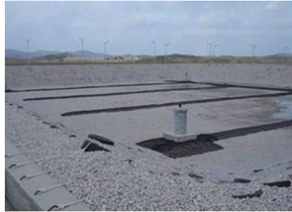
개성공단 내 폐기물처리시설 중 1단계로 설치된 폐기물매립시설 조성 완료 모습
