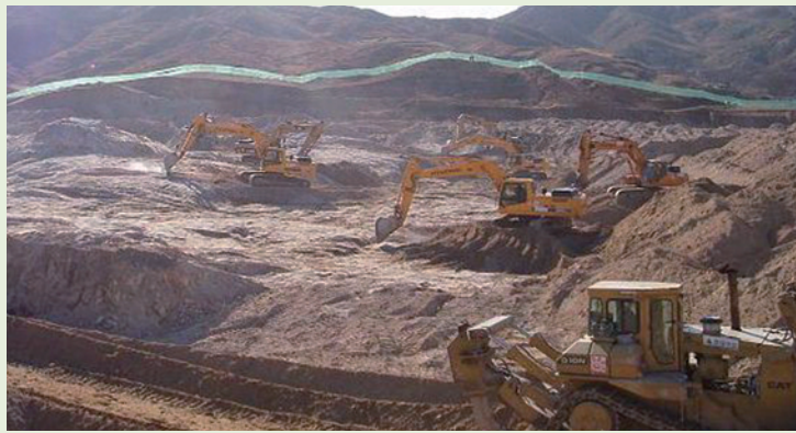
부지 조성을 위하여 포크레인과 불도저를 이용, 토사를 절취하고 있는 모습
