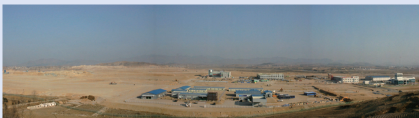
시범단지 입주업체 공장 건축이 진행중인 모습(2005.3)
