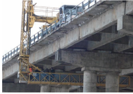
교량 상부 점검
