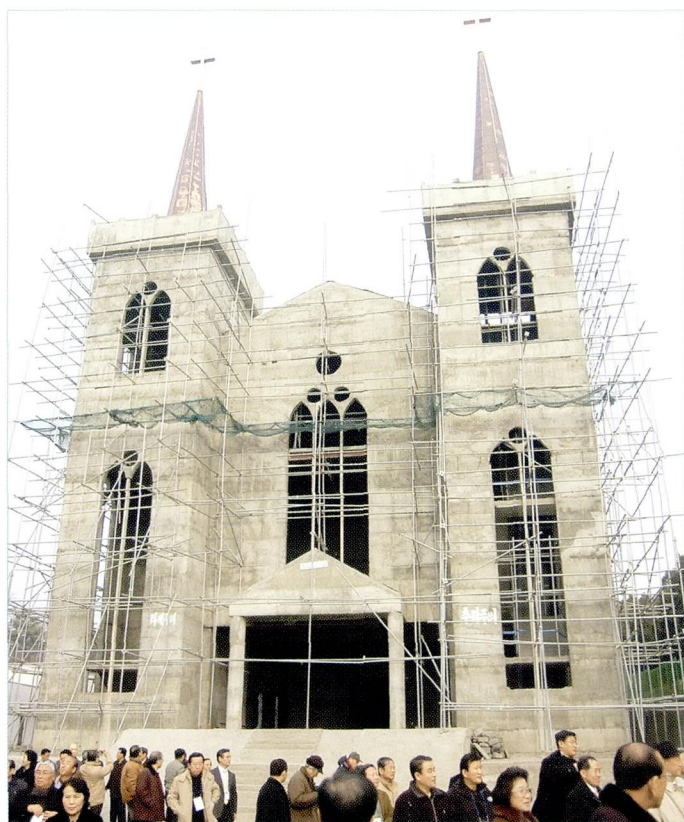
사진 ④-봉수교회 개축장면
