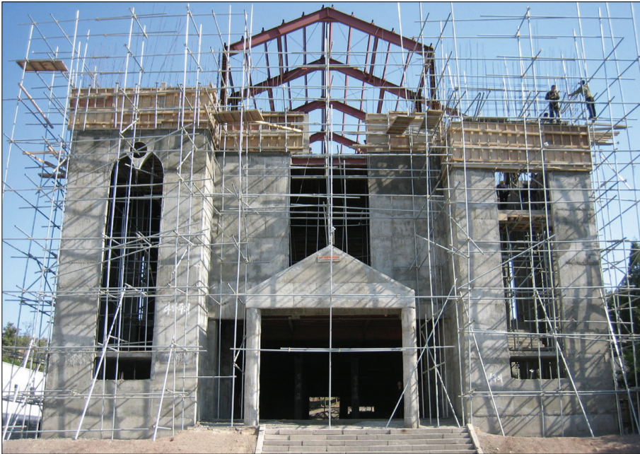
평양 봉수교회 재건축 현장
