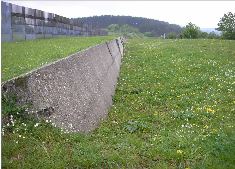
●그림 III-2 구동독에서 국경선에 설치했던 차량통과 방지 참호
